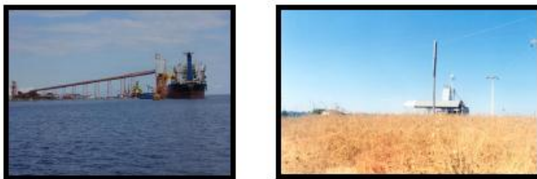
Figura 39 – Porto da Cargill e silos em Santarém (PA). Fonte: Zoneamento Ecológico Econômico da BR-163.
